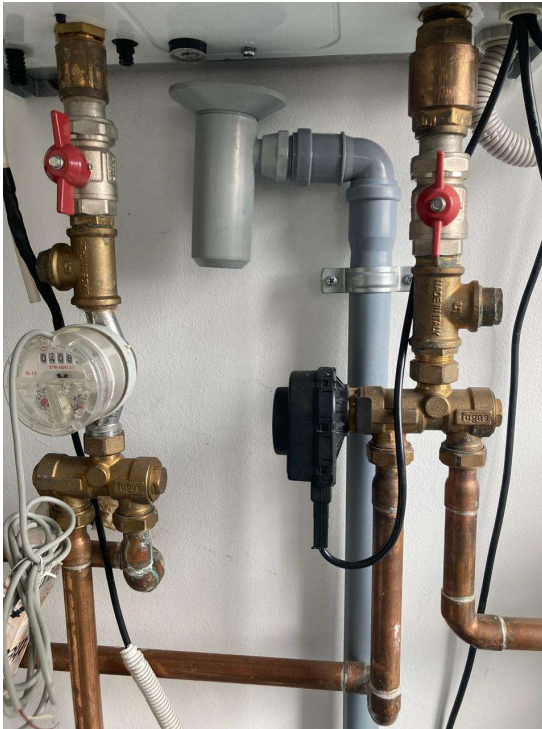
Рис. 2 Монтаж обратного клапана на лен.
