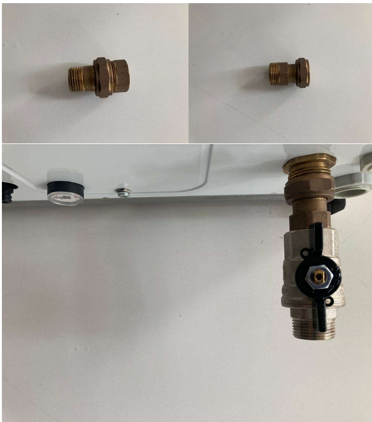
Рис. 7 Применение разборного соединения 1/2" под плоскую прокладку собранное наоборот и вкрученное к шаровый кран 3/4".
