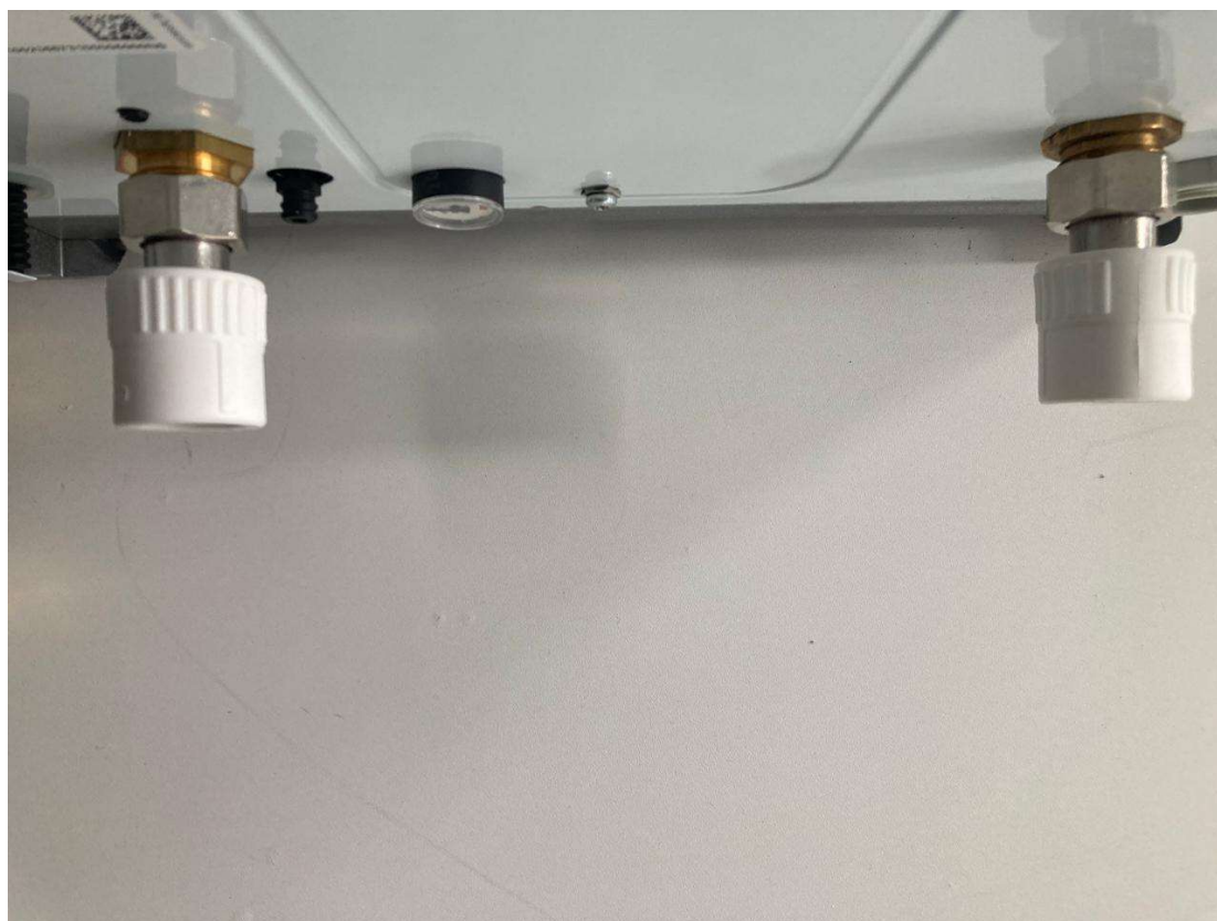
Рис. 6 Применение полипропиленовой комбинированной муфты накидной гайкой.
