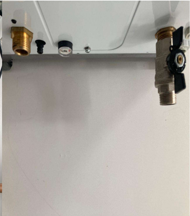
Рис. 3 Монтаж крана на анаэробный герметик
